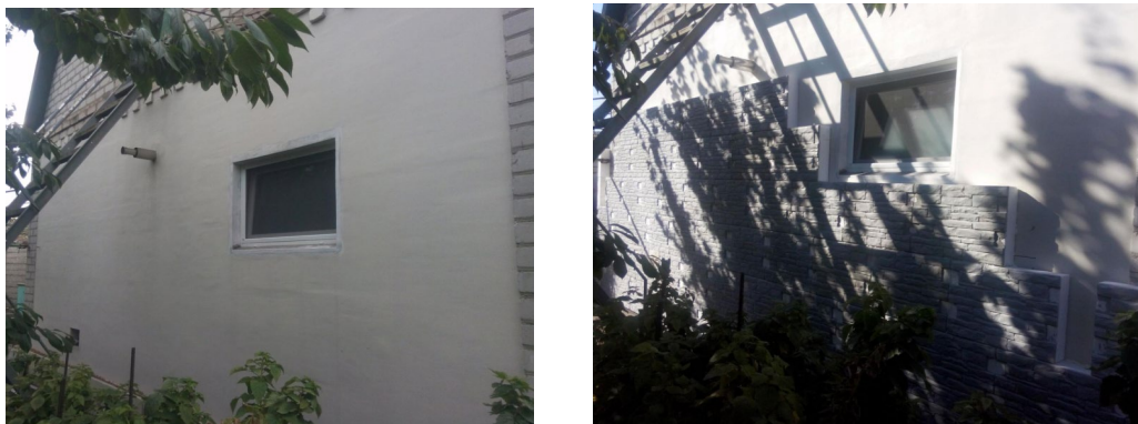
Рис 1. Фасад будівлі в процесі монтажу утеплювача
